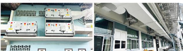
การติดตั้ง Fan Filter Unit ประกอบสำเร็จรูป เป็นชุดจากโรงงานได้มาตรฐาน ISO 9001 และ ISO 14001 ได้รับการรับรอง มาตรฐานผลิตภัณฑ์อุตสาหกรรม อก. 934-2533 และภายใต้ มาตรฐาน RoHS (จำกัดสารต้องห้ามในการผลิต) โดยติดตั้งพัดลม 1 จุ๊ดในแต่ละชั้นของอาคาร Fan Filter Unit แบบมีตัวรองอากาศ สามารถรองอากาศ เพื่อลดปริมาณฝุ่น PM2.5 ให้ได้ตามค่ามาตรฐาน ไม่เกิน 25 ไมโครกรัมต่อลูกบาศก์เมตร Fan Filter Unit Casing
