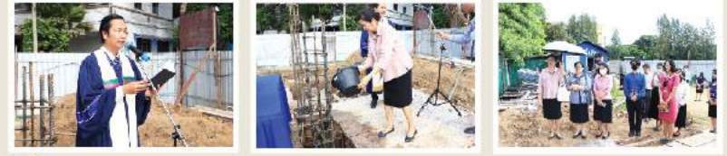
06 พิธีตั้งเสาเอกอาคารอำนวยการสวนเพชรรัตนฯ เมื่อ 25 สิงหาคม 2563
